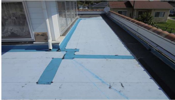
第1層目ルーフィングに常温粘着ルーフィングを施工
