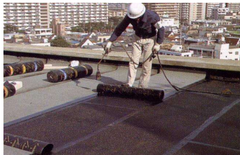
トーチ工法 施工風景
