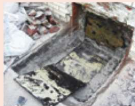
防水層切取り
