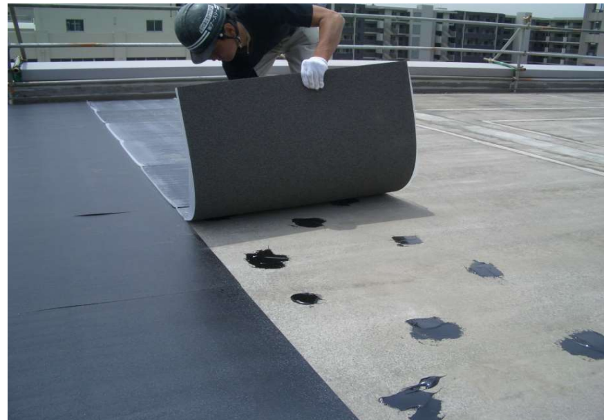
乾式アスファルトパネル 敷設
