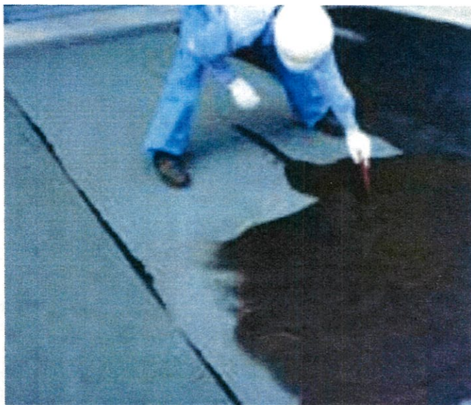
全面塗布時の施工状況
