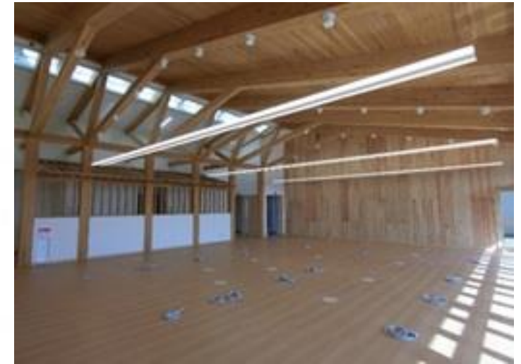
タスクアンビエント照明 (2階執務室)
