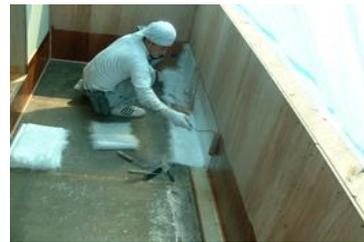
※例えば、既存のアスファルト防水を必ずしも同工法で全面改修する必要はありません。長寿命化のための防水改修工事は耐久年数や事業費、工期、施工難度等によって選定すべき材料・工法が異なります。
