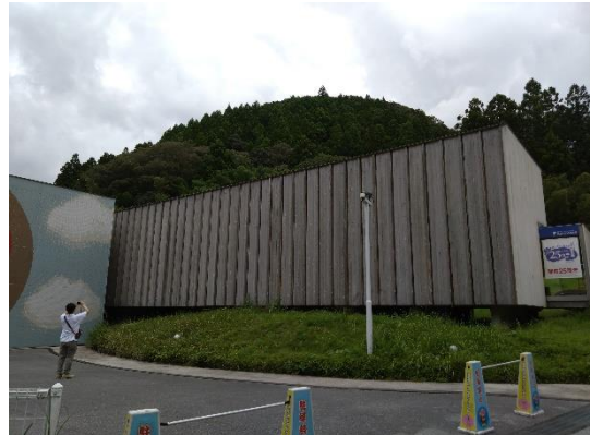
アンパンマンミュージアム別館（木造）
