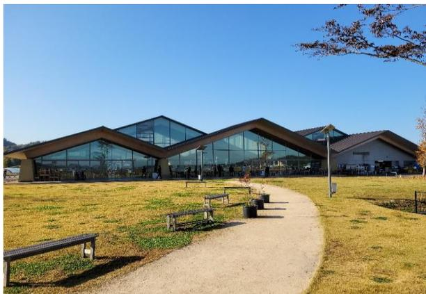
屋根を構成する大断面集成材は、小さな間隔で並べられて、谷の部分で鉄筋コンクリートの大きな立上りに接続することで、あたたかみのある大空間が創られています。
