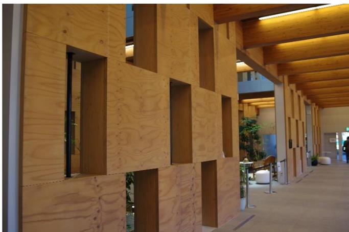
300mm の LVL のブロックを縦方向に市松状に積み上げ、その中に鋼棒を貫き水平力に抵抗する新たな技術を開発しました。これをメインの壁柱とし、現しにすることで特徴的な空間を作り出しています。この壁柱は、ポストテンションによる各ブロック接地面の摩擦抵抗力だけで水平せん断力を負担しており、約 50 トンもの水平耐力を持つもので、我々の間隔の外側であると感じました。建物中央部には吹き抜けのライトウェルがあり、1 階床の植栽に太陽光が降り注いでいます。上階のブリッジがその合間を縫って回遊性のある空間を形成しており、豊かなオフィス環境を作り出しています。そこに挿入された積層ブロック耐力壁が、その空間の魅力を引き出す為に有用なものとなっています。
