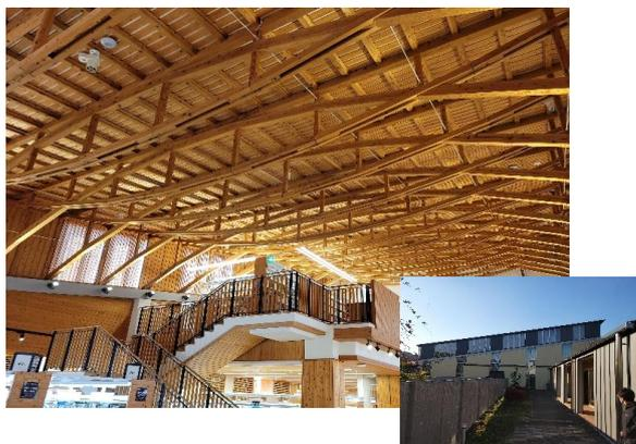
2段の片流れ屋根を持つ平屋の町民ギャラリーは垂木を重ねながら持ち出した架構。瓦葺の切妻屋根を持つ交流広場は桁方向に架け渡した平行弦トラス。
