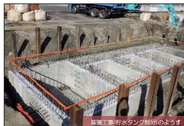
図 4-22 雨水貯留設備の例 (三春町)
