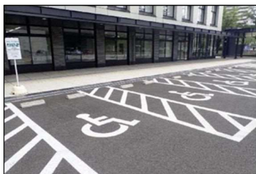
図 4-20 駐車場の事例 (福島県庁北庁舎)
