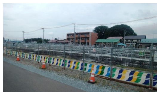
現場風景（基礎、地中梁配筋）その2
