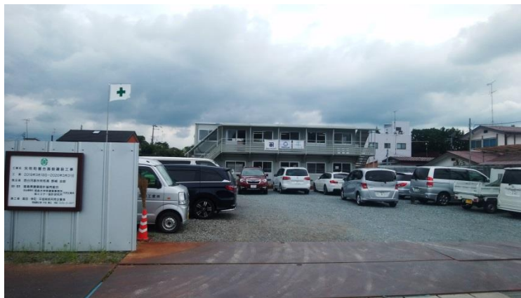
矢吹駅前の現場事務所
