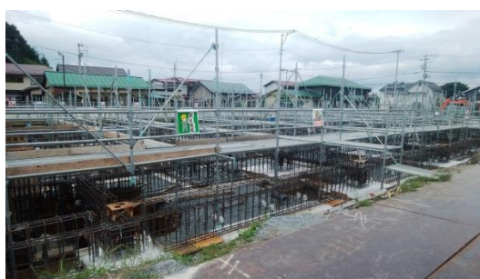
現場風景（基礎、地中梁配筋）その1
