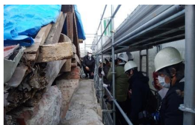
玄関上部ペディメント撤去部
