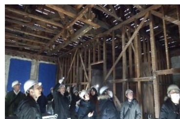
2 階内部撤去状況
