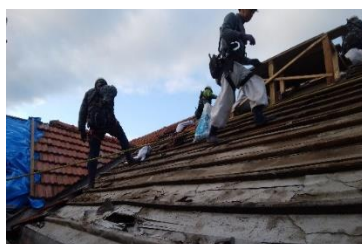
屋根材撤去部
