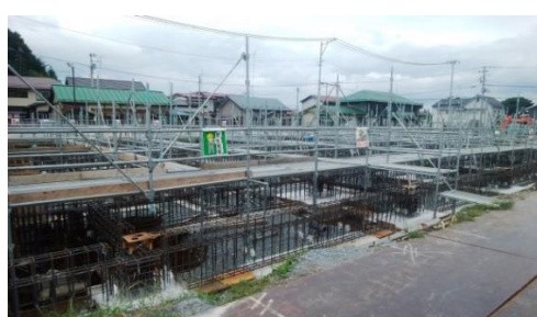
現場風景（基礎、地中梁配筋）
