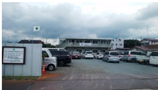
矢吹駅前の現場事務所
