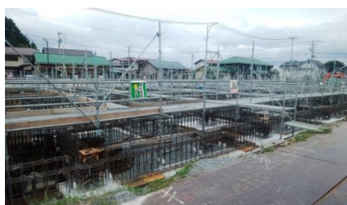
現場風景（基礎、地中梁配筋）
