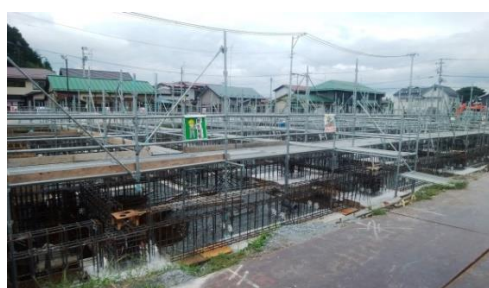
現場風景（基礎、地中梁配筋）
