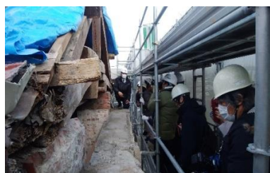
玄関上部ペディメント撤去部
