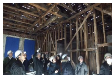
2階内部撤去状況
