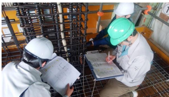
検査風景（柱・梁）
