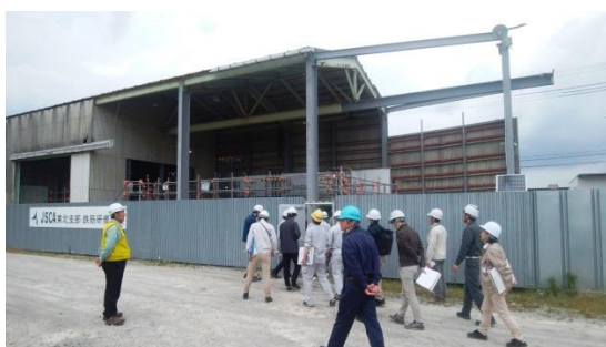
鉄筋モックアップ研修施設
