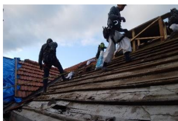
屋根材撤去部
